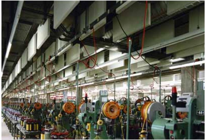
Bild 82: Akustikdecke in einem Textilbetrieb.
