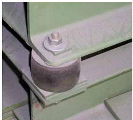
Bild 68: Gummielement für die Lagerung eines Ventilators.
