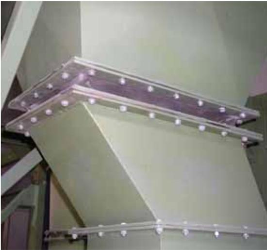
Bild 69: Kunststoff-Kompensator bei der Abluftleitung einer Prozessanlage.
