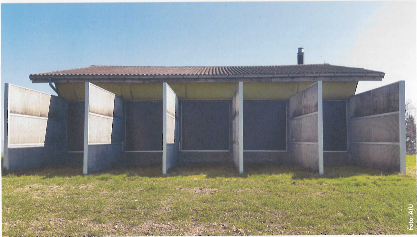
Lärmschutzwände dämmen den Mündungsknall und je nach Länge auch den Geschosknall (Beispiel Buttwil).
